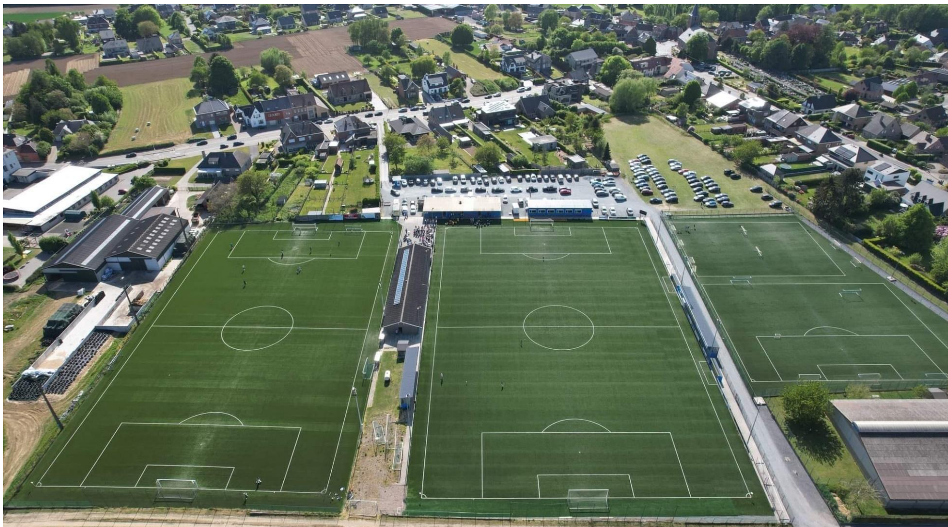
Afbeelding 2 Obliëk luchtbeeld van de site
